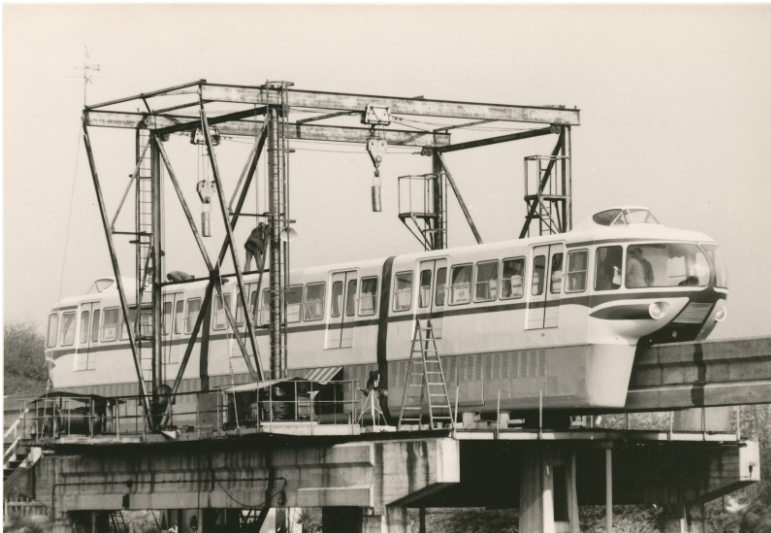
ALWEG-Bahn in Köln-Fühlingen: Montage des für die Jahrtausendausstellung in Turin entwickelten Modells "Italia 1961" (1960/61). Fotograf/Urheber: unbekannt
