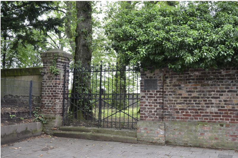
Der Eingangsbereich des jüngeren Jüdischen Friedhofs in der Mansfeldstraße in Düsseldorf-Gerresheim (2014). Fotograf/Urheber: Suzan Leblebici
