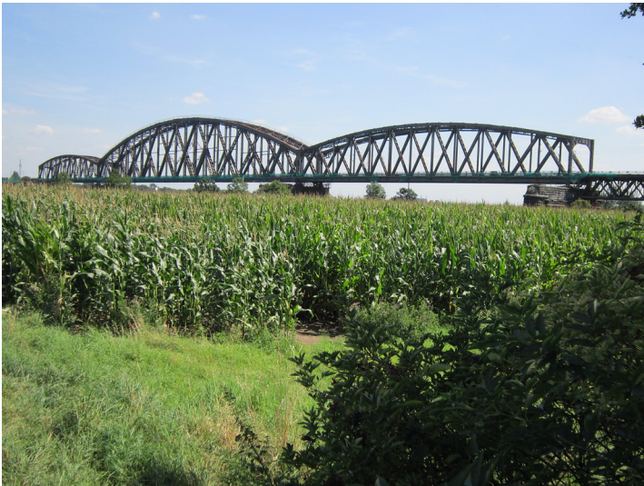
Haus-Knipp-Brücke bei Baerl von Norden (2012) Fotograf/Urheber: Weber, Claus
