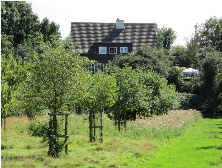
Empfangsgebäude des Bahnhofes Baerl in Duisburg, Blick von Norden (2012). Fotograf/Urheber: Claus Weber
