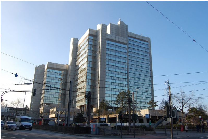
Neues Stadthaus am Berliner Platz (2012) Fotograf/Urheber: Bolte, Anna-Maria
