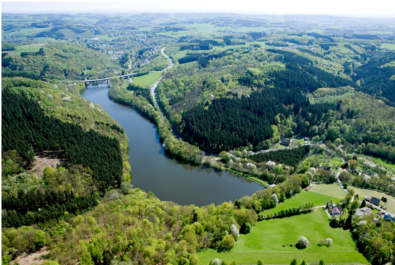
Luftbild des Biebersteiner Stausees, Wiehl (2009) Fotograf/Urheber: Arendt, Stefan
