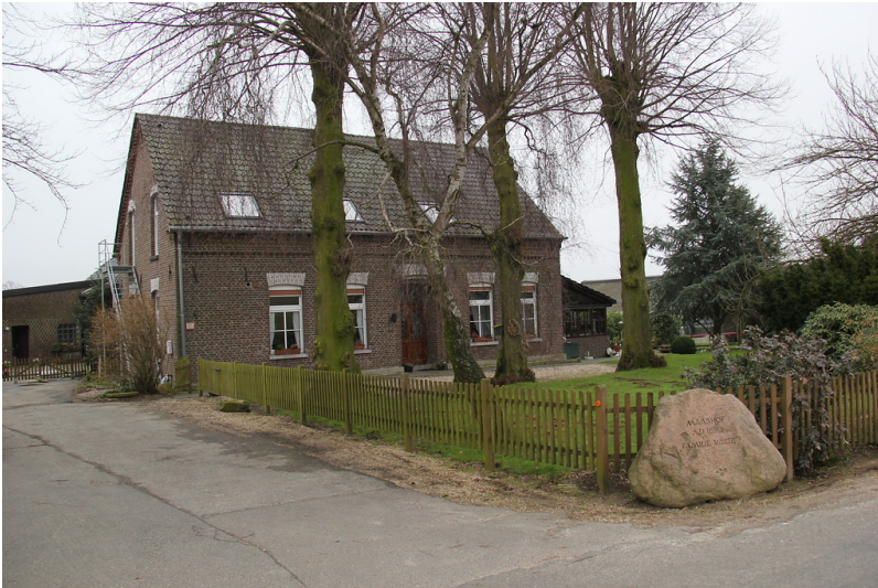
Wohnhaus des Maashofes in Uedem-Uedemerfeld (2013) Fotograf/Urheber: Peter Burggraaf
