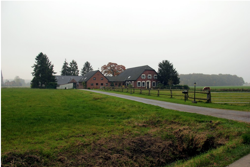
Der Hof "Giekenkath" an der Holländischen Straße in Uedemerbruch (2012). Fotograf/Urheber: Peter Burggraaff
