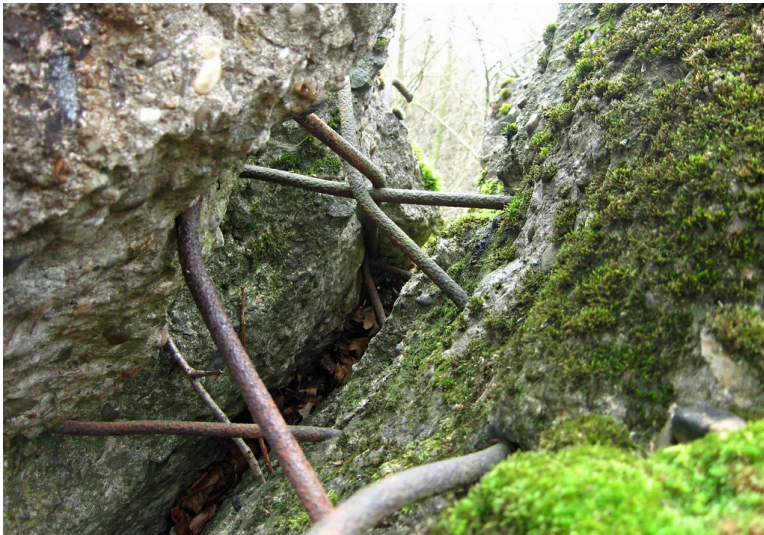
Stahlbetonreste in der Ruine des ehemaligen „Führerhauptquartiers Felsenest“ bei Rodert (2012) Fotograf/Urheber: Franz-Josef Knöchel
