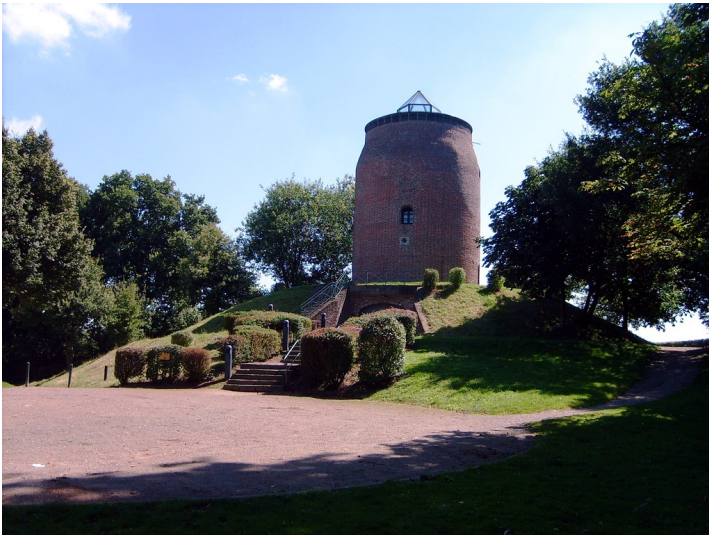
Hohe Mühle in Uedem (2012) Fotograf/Urheber: Burggraaff, Peter
