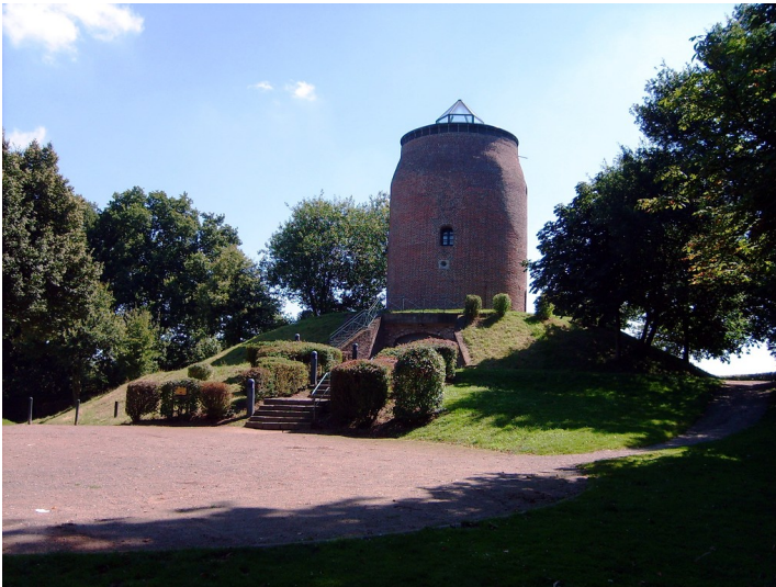
Hohe Mühle in Uedem (2012) Fotograf/Urheber: Burggraaff, Peter
