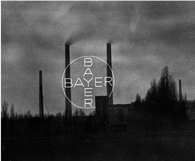
Das alte Bayer-Kreuz in Leverkusen zwischen den Kaminen des G-Kraftwerks (1933) Fotograf/Urheber: Bildarchiv der Bayer AG
