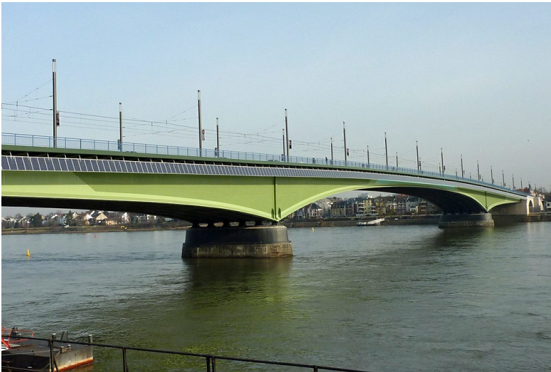
Kennedybrücke (Rheinbrücke Bonn-Beuel) (2012) Fotograf/Urheber: Schulz, Katharina
