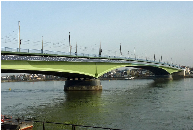
Kennedybrücke (Rheinbrücke Bonn-Beuel) (2012) Fotograf/Urheber: Schulz, Katharina
