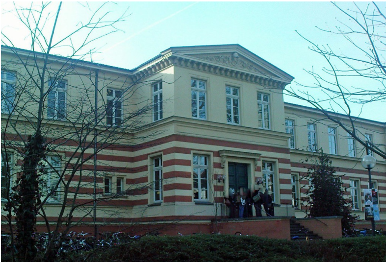
Altes Chemisches Institut, Meckenheimer Allee 166-168 (2012) Fotograf/Urheber: Voigt, Julia, GIUB, 2012
