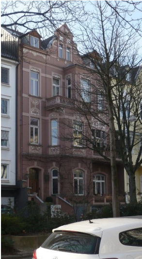
Gründerzeithaus, Baumschulallee 3 (2012) Fotograf/Urheber: Jost Dockter
