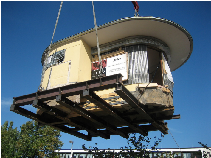
Ein Kran hebt das denkmalgeschützte "Bundesbüdchen", einen Kiosk im Bonner Regierungsviertel an, um diesen zu seinem Zwischenlager, einem Bauhof in Hersel, transportieren zu können (2006).
