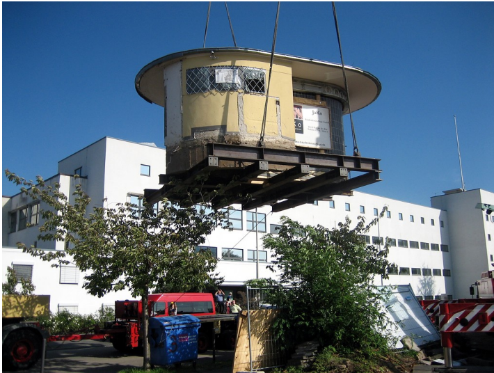
Ein Kran hebt das denkmalgeschützte "Bundesbüdchen" - einen Kiosk im Bonner Regierungsviertel an, um diesen zu seinem Zwischenlager, einem Bauhof in Hersel, transportieren zu können (2006). Fotograf/Urheber: Wolfgang Schlesener
