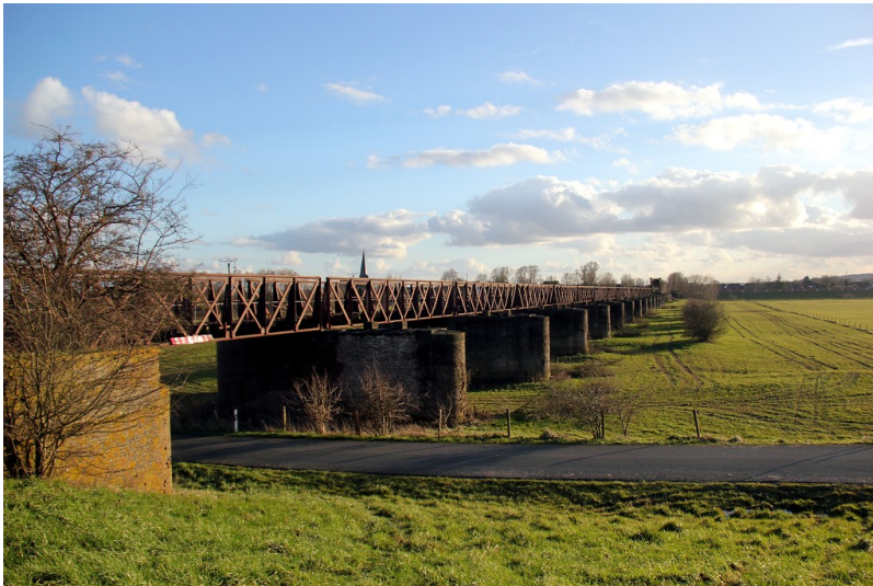
Der Hochwasserbrücke der Griethausener Eisenbahnbrücke in der Rheinaue (2016) Fotograf/Urheber: Peter Burggraaf
