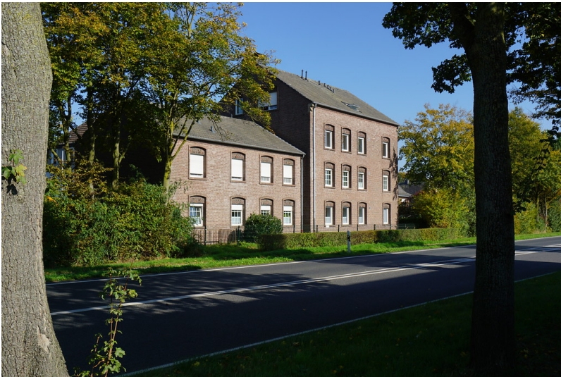
Empfangsgebäude des Bahnhofes Uedem (2017) Fotograf/Urheber: Claus Weber
