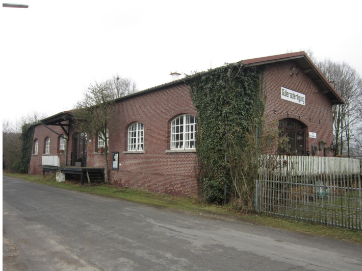
Ehemalige Güterabfertigung Bahnhof Hassum (2017) Fotograf/Urheber: Claus Weber
