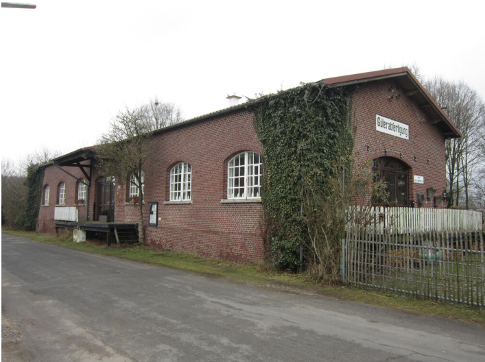
Ehemalige Güterabfertigung Bahnhof Hassum (2017) Fotograf/Urheber: Claus Weber
