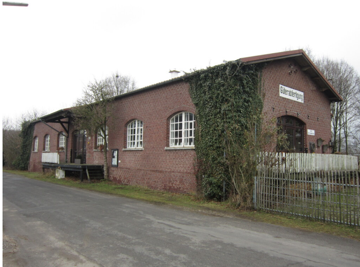
Ehemalige Güterabfertigung Bahnhof Hassum (2017) Fotograf/Urheber: Claus Weber
