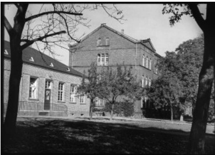
Arbeitshaus in der ehemaligen Abtei Brauweiler, Frauenhaus um 1920 Fotograf/Urheber: Fotoatelier Hengeler & Grümmmer, Köln-Dellbrück
