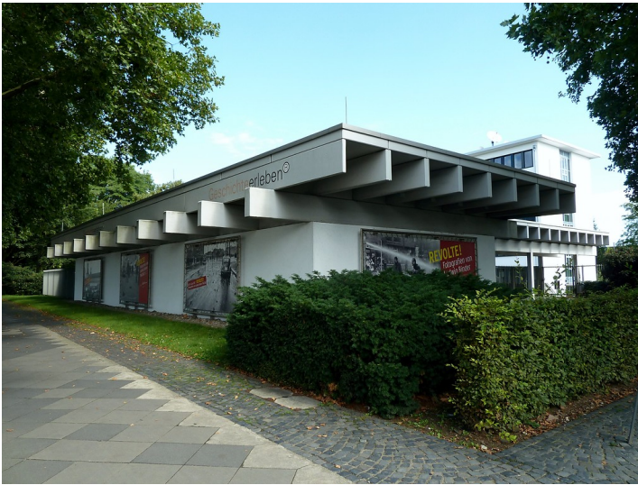
Pavillon Ecke Willy-Brandt-Allee / Welckerstraße in Bonn (2017) Fotograf/Urheber: Katrin Becker
