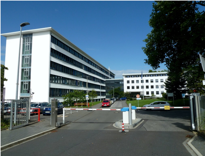
Presse- und Informationsamt der Bundesregierung in der Welckerstraße in Bonn (2017). Fotograf/Urheber: Katrin Becker
