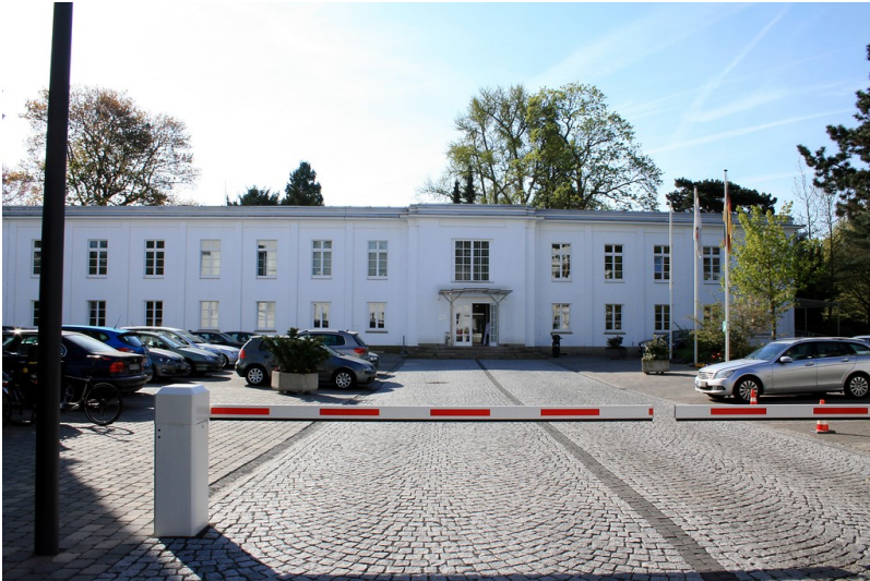
Verwaltungsgebäude Kaiser-Friedrich-Straße 16 im Park der Villa Hammerschmidt, heute Bundeskartellamt (2015) Fotograf/Urheber: Christoph Montforts
