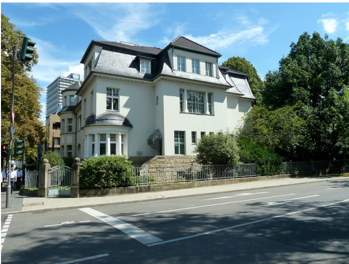
Wohnhaus Heussallee 18/20 in Bonn, Ansicht von Westen (2017). Fotograf/Urheber: Katrin Becker
