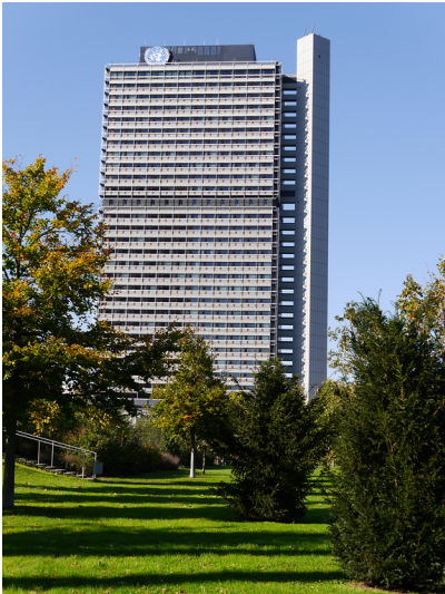
Ehemaliges Abgeordnetenhochhaus Langer Eugen in Bonn (2014) Fotograf/Urheber: Knaack, Andje
