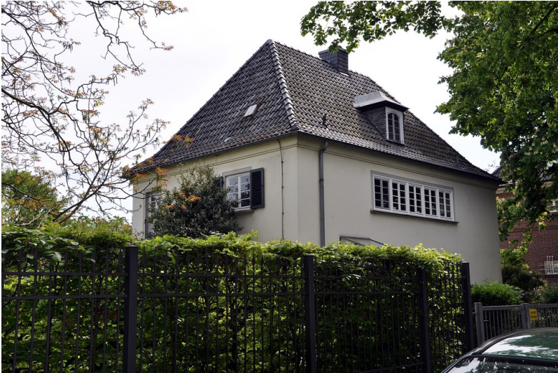
Wohnhaus Friedrich-Wilhelm-Straße 12 im Bonner Regierungsviertel (2016) Fotograf/Urheber: Felicitas Gildenhard
