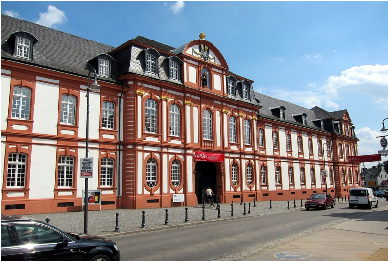
Der Westflügel der ehemaligen Benediktinerabtei Brauweiler mit dem heutigen Haupteingang an der Ehrenfriedstraße (2013).
