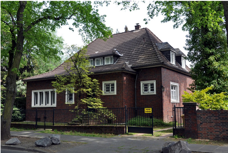
Wohnhaus Friedrich-Wilhelm-Straße 4 im Bonner Regierungsviertel (2016) Fotograf/Urheber: Felicitas Gildenhard
