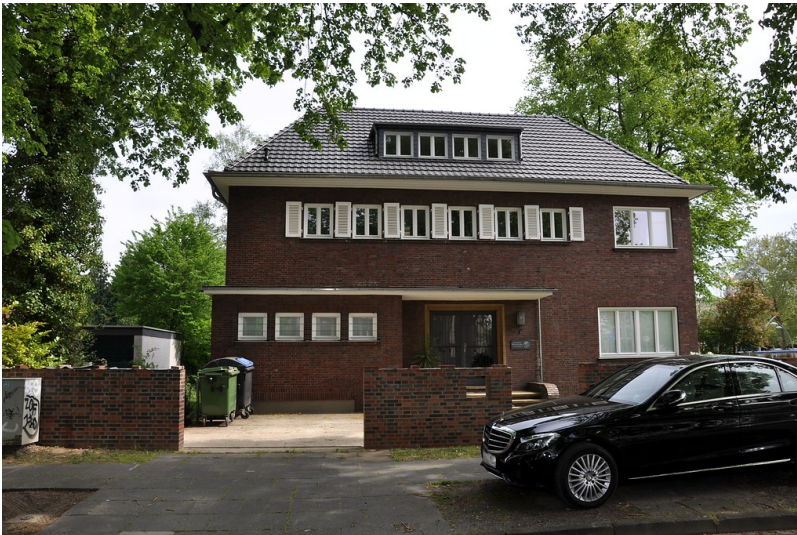
Wohnhaus Friedrich-Wilhelm-Straße 2 im Bonner Regierungsviertel (2016) Fotograf/Urheber: Felicitas Gildenhard
