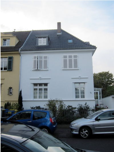
Frontansicht des Wohnhauses Eduard-Pflüger-Straße 50 in Bonn (2014) Fotograf/Urheber: Knieps, Elmar
