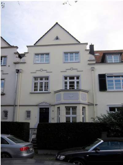
Frontansicht des Wohnhauses Coburger Straße 1b in Bonn (2014) Fotograf/Urheber: Knieps, Elmar
