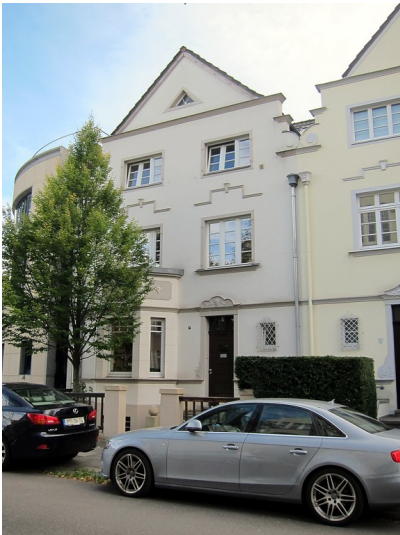
Frontansicht des Wohnhauses Coburger Straße 1a in Bonn (2014) Fotograf/Urheber: Knieps, Elmar
