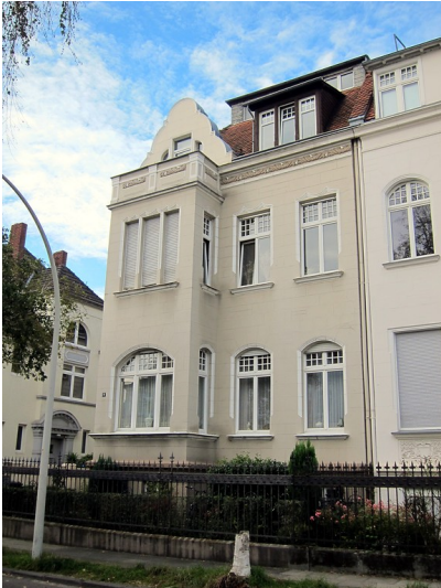
Frontansicht des Wohnhauses Coburger Straße 4 in Bonn (2014) Fotograf/Urheber: Knieps, Elmar
