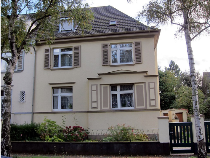
Frontansicht des Wohnhauses Coburger Straße 21 in Bonn (2014) Fotograf/Urheber: Knieps, Elmar
