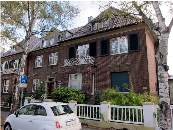
Frontseite des Wohnhauses Coburger Straße 13 in Bonn (2014) Fotograf/Urheber: Knieps, Elmar
