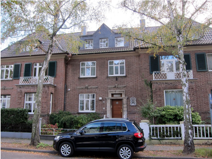
Frontseite des Wohnhauses Coburger Straße 11 in Bonn (2014) Fotograf/Urheber: Knieps, Elmar
