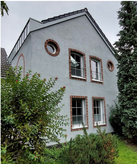
Rückwärtige Ansicht der früheren Synagoge Zündorf mit der 2020/21 wieder hergestellten Fenstergliederung samt den ursprünglichen Rundbogenfenstern (2022). Fotograf/Urheber: Franz-Josef Knöchel
