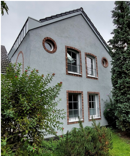
Rückwärtige Ansicht der früheren Synagoge Zündorf mit der 2020/21 wieder hergestellten Fenstergliederung samt den ursprünglichen Rundbogenfenstern (2022). Fotograf/Urheber: Franz-Josef Knöchel
