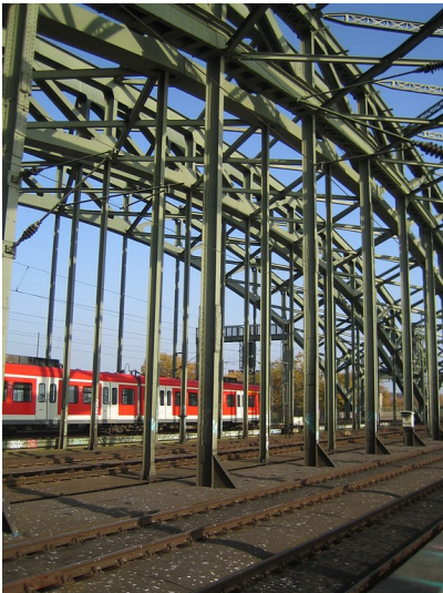
Teilsicht der Kölner Hohenzollernbrücke mit einer die Brücke befahrenden S-Bahn im Hintergrund (2012). Fotograf/Urheber: Knieps, Elmar
