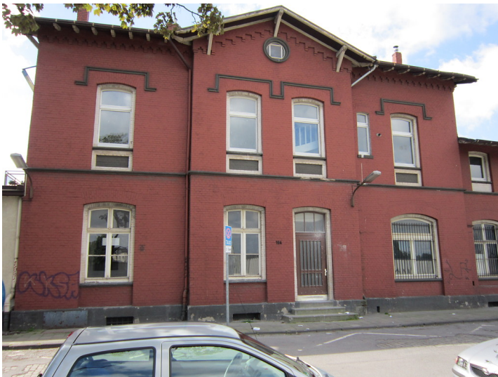
Das Empfangsgebäude des Bahnhofes Gerresheim, von der Straßenseite gesehen (2012) Fotograf/Urheber: Weber, Claus
