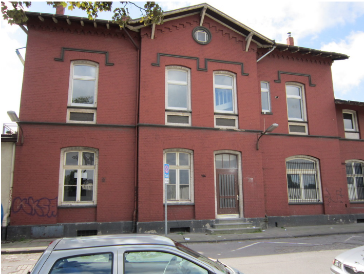
Das Empfangsgebäude des Bahnhofes Gerresheim, von der Straßenseite gesehen (2012) Fotograf/Urheber: Weber, Claus
