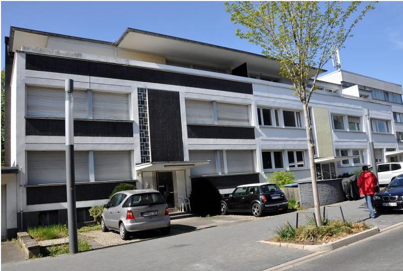
Bürohäuser in der Karl-Carstens-Straße (Nm. 12, 14 und 16) in Bonn (2015) Fotograf/Urheber: Becker, Katrin
