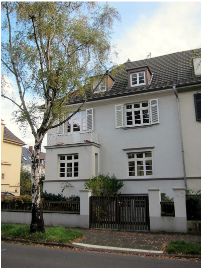
Frontansicht des Wohnhauses Coburger Straße 23 in Bonn (2014) Fotograf/Urheber: Knieps, Elmar
