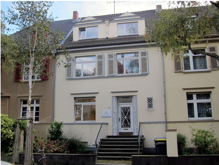
Frontansicht des Wohnhauses Coburger Straße 19 in Bonn (2014) Fotograf/Urheber: Knieps, Elmar
