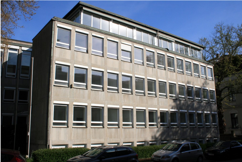
Das Bürogebäude Adenauerallee 131a / Ecke Kaiser-Friedrich-Straße im Bonner Regierungsviertel (2015). Fotograf/Urheber: Montforts, Christoph
