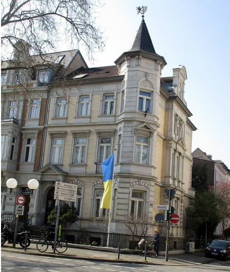
Das 1889/90 erbaute dreigeschossige Eckwohnhaus an der Ecke Adenauerallee / Arndtstraße in Bonn-Gronau (2022). Fotograf/Urheber: Franz-Josef Knöchel
