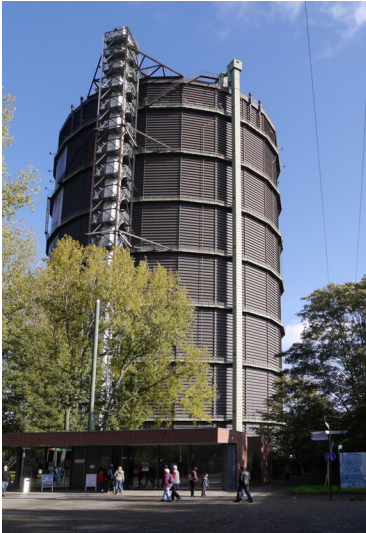
Gasometer in Oberhausen (2019) Fotograf/Urheber: Andje Knaack
