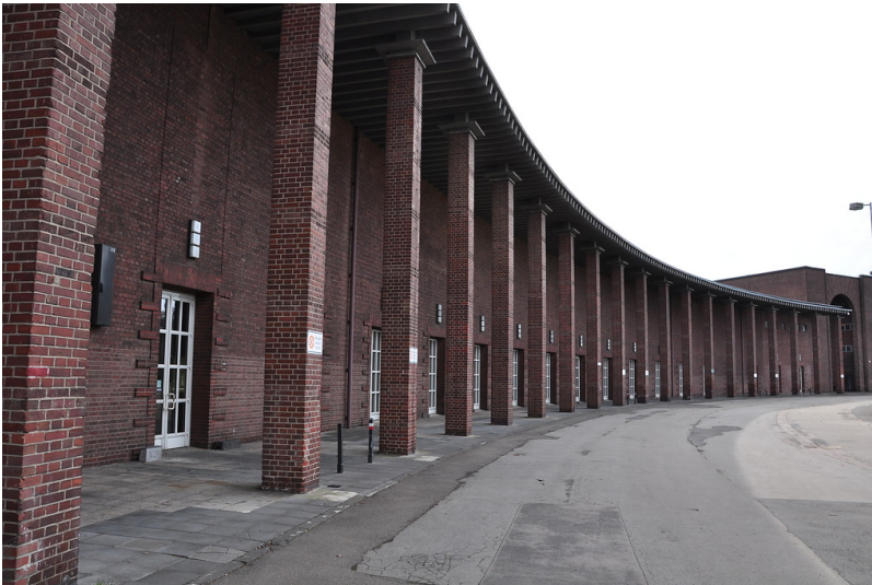
Fassade des Staatenhauses am Tanzbrunnen Fotograf/Urheber: Lagodny, Fabian
