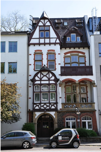
Wohn- und Bürohaus, Adenauerallee 85 in Bonn (2016) Fotograf/Urheber: Felicitas Gildenhard
