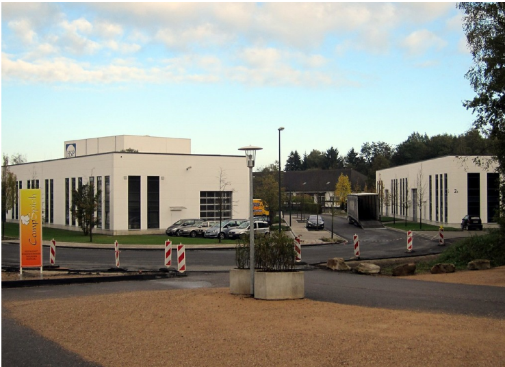
Teil der ehemaligen Kasernenanlage Camp Roi Baudouin (Kamp Koning Boudewijn), heutiges Gewerbegebiet Camp Spich (2011) Fotograf/Urheber: Knöchel, Franz-Josef
