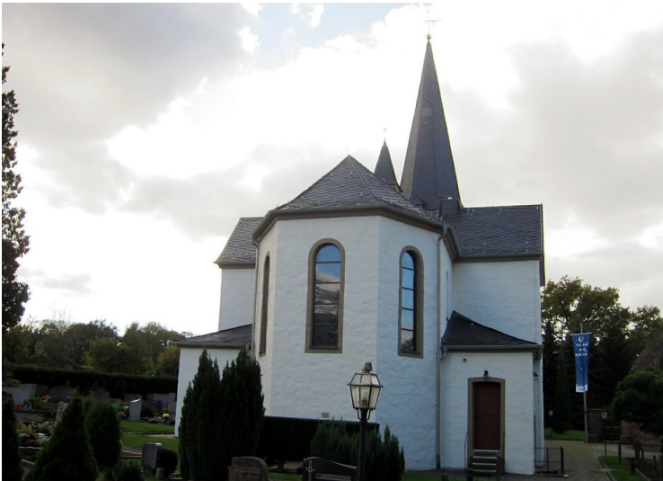
Pfarrkirche an der Flughafenstraße in Altenrath (2011) Fotograf/Urheber: Knöchel, Franz-Josef, LVR-Redaktion KuLaDig
